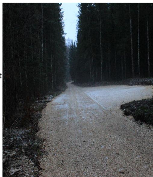
Techniquement, le chantier a nécessité, entre autres, la remise au gabarit de la route existante et d'importants travaux de terrassement (800 m<sup>3</sup> de concassé pour la partie Dommartin).
